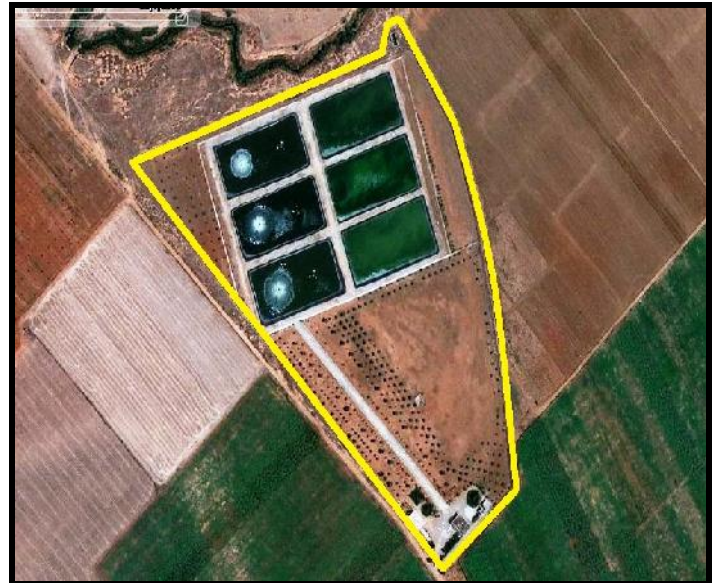
Figure N°12 : La station de lagunage aéré de GHRISS
