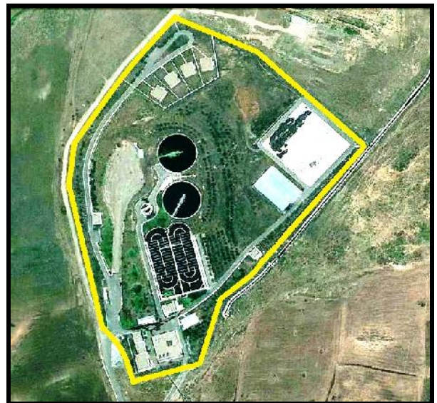
Figure N°18 : La STEP de SIDI MEROUANE
