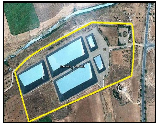
Figure N°13 : La station de lagunage naturel d'OUED TARIA
