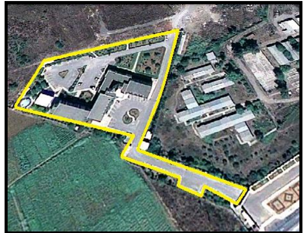
Figure N°01: siège de la Direction Générale de l'ONA
