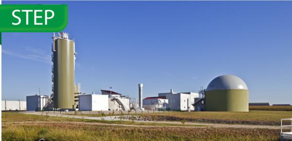
*La station d'épuration de la capitale française de la choucroute, Krautergersheim est au point à plus d'un titre. Non seulement, le traitement des eaux usées permet de produire de l'énergie, mais un deuxième méthaniseur transforme aussi le jus de choucroute, en biogaz.*
