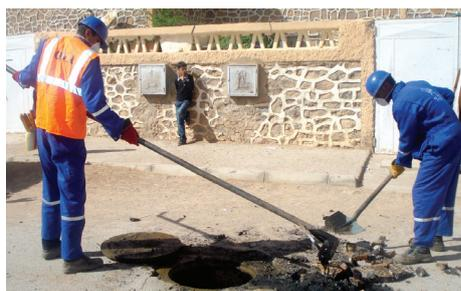
Le curage manuel est un procédé qui consiste à enlever les déchets stagnants manuellement dans les regards et autres ouvrages tels que la chambre à sable et le déversoir d'orage afin de protéger les canalisations et éviter le colmatage par les déchets des réseaux d'assainissement.
